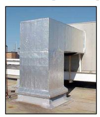
La gaine de protection contre les intempéries Alumaguard® Lite de Polyguard Products est l'un des produits de gainage de la famille Alumaguard qui offre une performance supérieure à basse température, une manipulation et une application aisées, et une véritable performance de perméabilité zéro.
